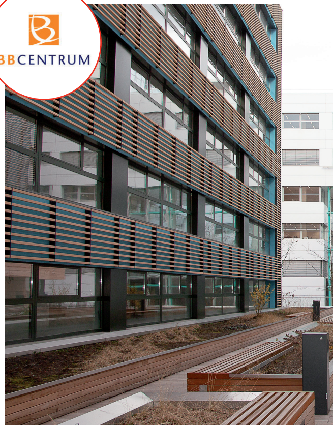
BB Centrum – multifunkční areál – Praha
